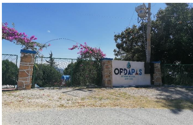
Instalaciones de OPDAPAS al norte de la cabecera municipal
